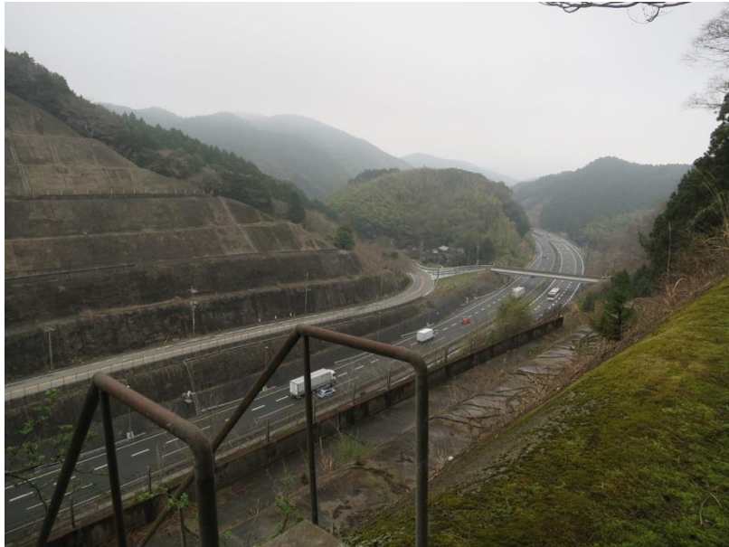
【擁壁上部から高速道路を見下ろして】
