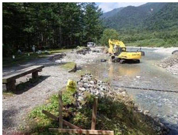
<小梨平の川岸決壊場所の修復工事>
