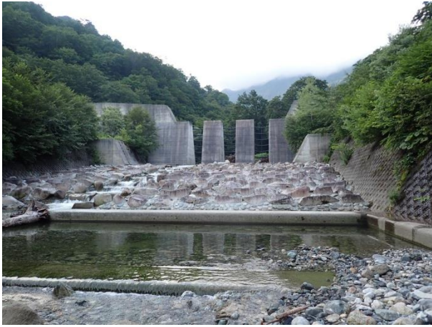
巨大なスリットダム
