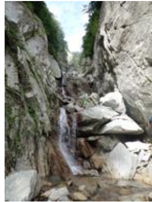
崩壊が進む連瀑ゴルジュ帯
